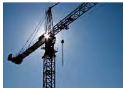
HEBEN IM BAUWESEN
