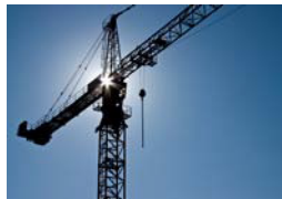
HEBEN IM BAUWESEN
